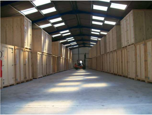
Garde meubles Vue Générale
